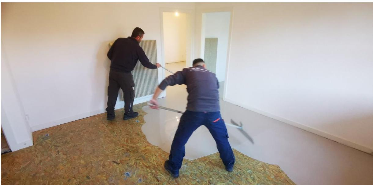
Hier sind die Arbeiten voll im Gange, die Versiegelung des neuen Boden. Auch der Untergrundboden wurde entsprechend ersetzt und verstärkt, sodass es kein Knarren beim begehen mehr gibt.
